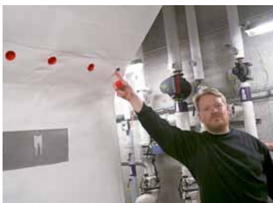
Før ombygningen bliver luftflowet omhyggeligt målt gennem små huller boret i ventilationskanalen.
